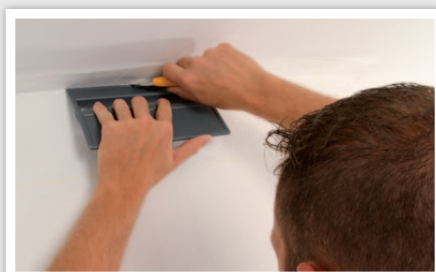
14 Araser au niveau du plafond.
